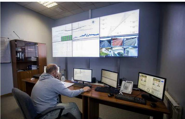
Приборный мониторинг всех элементов моста проводят отдельная диспетчерская группа. На вантовом мосту установлено огромное количество оборудования, в том числе более 500 различных датчиков. Такие показатели, как натяжение вант, метеорологические условия, скорость ветра, состояние дорожного движения и многие другие выводятся на экраны в центре мониторинга. За всеми процессами специалисты следят в реальном времени.
